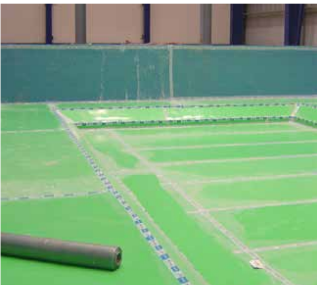
Instalación de SYLOMER para la cimentación de una máquina
