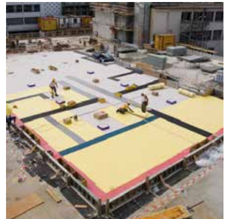
Suspensión flotante de un edificio con SYLOMER
